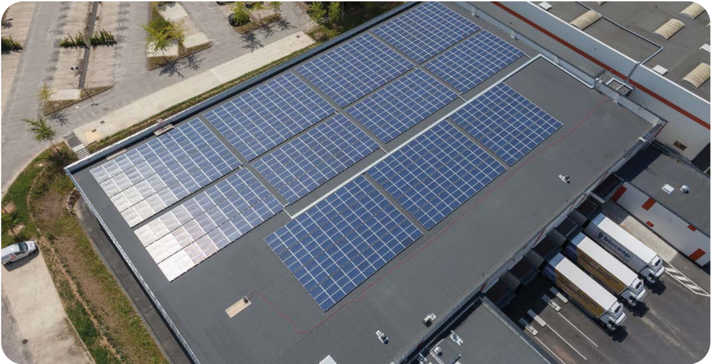
Crédit photo : Nexhos énergies
