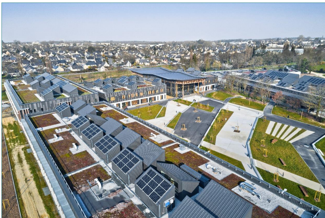
Construction du Lycée Simone Veil à Liffré (35) : vue sur les toits végétalisés et les panneaux photovoltaïques © Jérôme Sevrette
