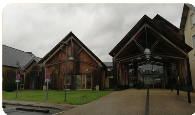
Etablissement de santé de la Sarthe ayant bénéficié d'un diagnostic solaire thermique
