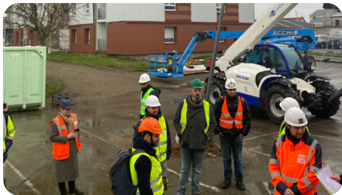
Visite d'un chantier du programme Energie Sprong Pays de la Loire au Mans (72) avec Novabuild.
