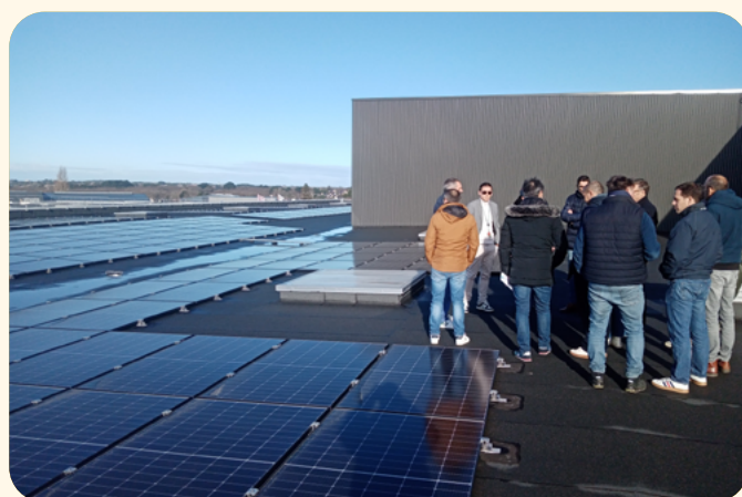
Visite d'une installation solaire avec des entreprises de Saint-Nazaire agglo (44)
