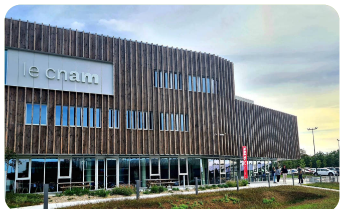
Cnam de la Roche-sur-Yon, bâtiment où seront dispensées les formations
