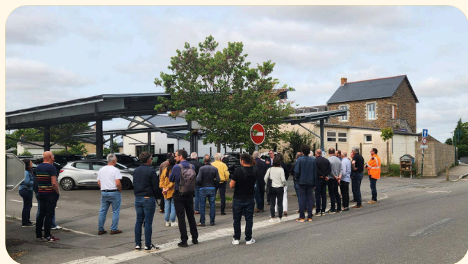
Visite des installations photovoltaïques dans la commune de Pipriac (35)
