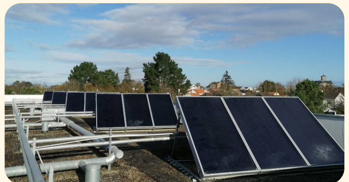
Réhabilitation de l'installation de l'EHPAD Croix du Gué, Bouguenais (44)
